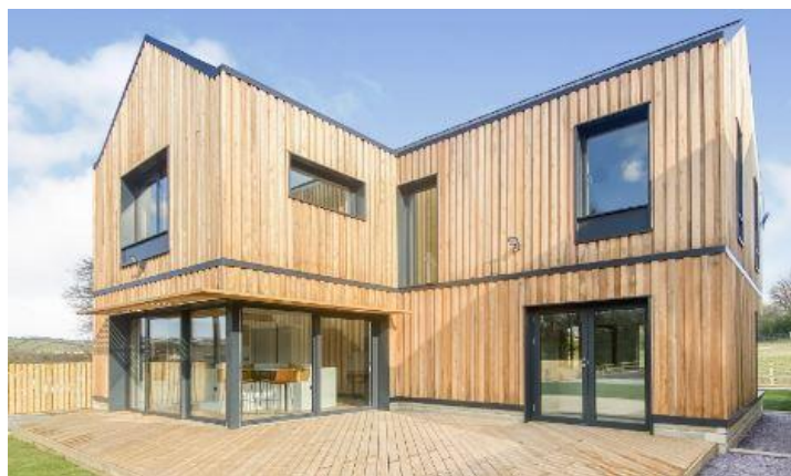
Dieses Passivhaus im britischen Bradford öffnet seine Türen ebenfalls zu den Tagen der offenen Tür, ID 6447. © Purehaus
